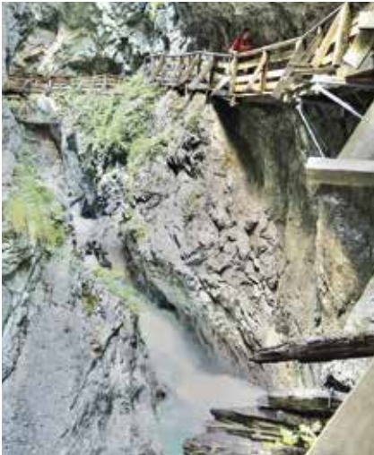
Über einen hölzernen Steg führt der Weg durch die Wolfsklamm.
